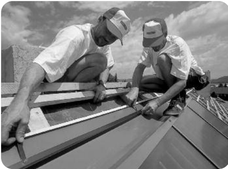
Alumínium profil behelyezése
