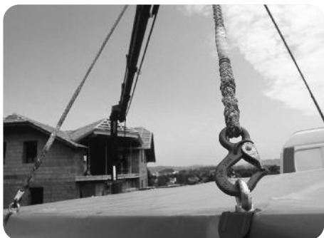
Az emelőkötel kampójának beasztása a kollektor függesztő-pontjaiba. A biztos felfüggesztést ellenőrizni kell.
