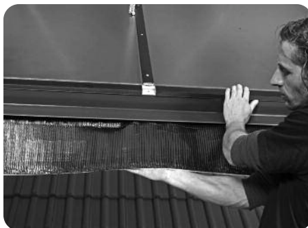
Kollektor köpeny részének kihajtása
