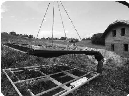
A kollektor felemelése a raklapról
