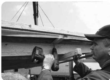
A raklap eltávolítása a kollektorról (6 db 5 x 80T x 25 csavar)
