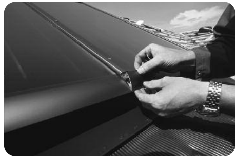
A takarólemez a kollektor alsó részén lévő csavarok elfedésére szolgál.
