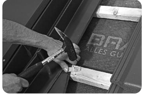
A kollektor burkolókeretének külső élét oldalt fent rögzíteni kell a tetőléchez, hogy a cserepek a lehető legjobban felfeküdjenek a tetőre.
