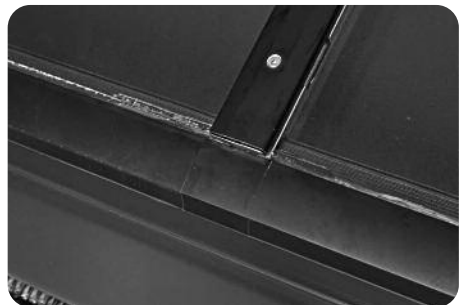
Azokat alsó oldaluknál fogva a helyükre kell pattintani. Az ereszdalon lévő köpenyt a fedőanyag profiljára kell formázni. A köpeny hátdoldalán ragasztósáv található. A védőfólia eltávolítása után a köpenyt a fedőanyagra kell préselni. A ragasztási felület legyen száraz és pormentes.
