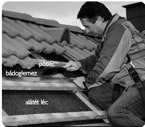
rögzítőléc felszerelése
