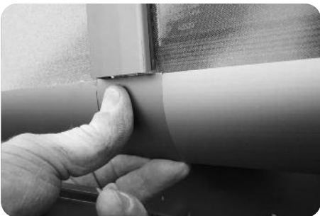
Azokat alsó oldaluknál fogva a helyükre kell pattintani. Az ereszdalon lévő köpenyt a fedőanyag profiljára kell formázni. A köpeny hátdoldalán ragasztósáv található. A védőfólia eltávolítása után a köpenyt a fedőanyagra kell préselni. A ragasztási felület legyen száraz és pormentes.
