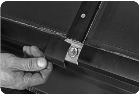
A takarólemez a kollektor alsó részén lévő csavarok elfedésére szolgál.
